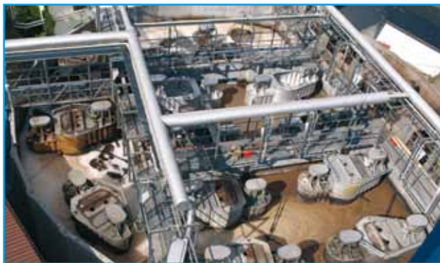
Aeraatorid Rockhamari (Rootsi) tselluloositööstuse reoveepuhastus-seadmetes. Seadmed on valmistanud ja paigaldanud AS J.I.T. Rootsi firma Celpateknika litsentsi alusel. Seadme on välja töötanud 90 aastat tagasi Viljandis sündinud Eesti insener Rudolf Woode. Praegu juhivad firmat pojad Erik ja Jaan Woode. Seadme nimi on Celpox 1910. J.I.T. töökojas on ka töötav mudel, mida saab huvilistele demonstreerida.
