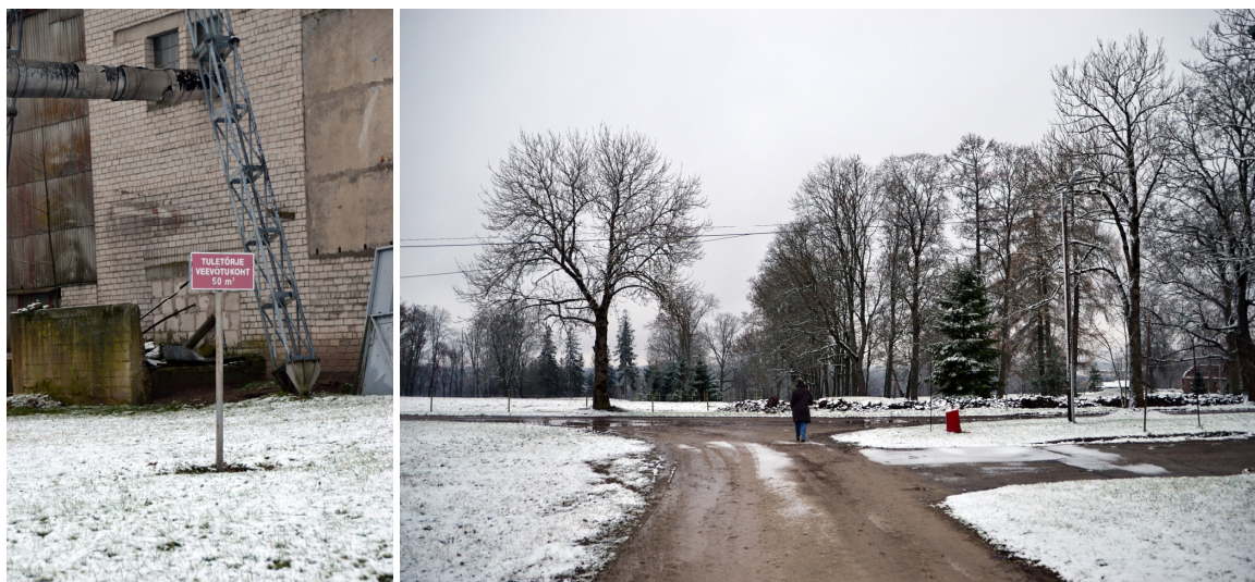
Foto 3. Vasakul: Vaade Kannikmäe tee ääres paiknevale tuletõrje veevõtukohale Tobra tee 4 maaüksusel. Paremal: Vaade olemasolevale veehüdrandile ja selle kõrval paiknevale spordihalli juurdepääsuteele. Fotod: Kobras AS, K. Kattai, 12. 2017.
