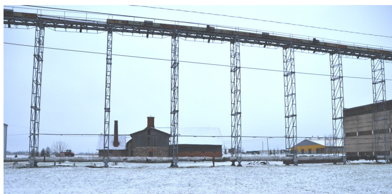
Foto 5. Vaade ehitismälestisele edelasuunast (Kannikmäe teelt). Foto: Kadri Kattai, Kobras AS, 2017.
