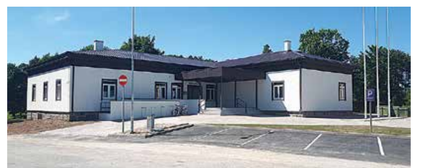
Nii Viiratsi rahvamaja fassaad kui hoone ümbrus on saanud ehitustööde käigus tunduvalt kaunimaks.
