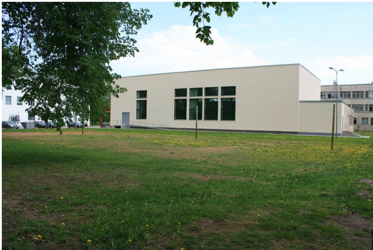
Foto 2. Renoveeritud Tarvastu Gümnaasiumi võimla (vaade läänest)
