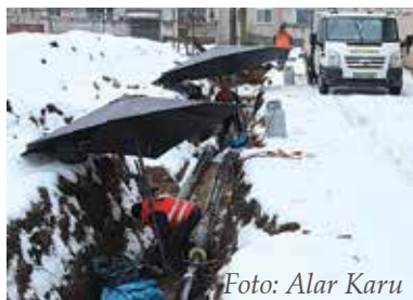
Foto: Alar Karu Kaugkütte soojatorustike rekonstrueerimine lõppes tänava kevadel.
