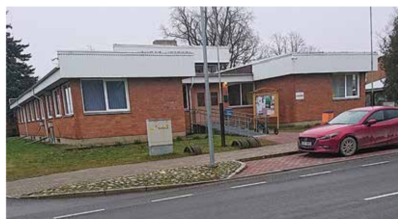
Kolga-Jaani kunagises vallamajas töötab palju inimesi.
