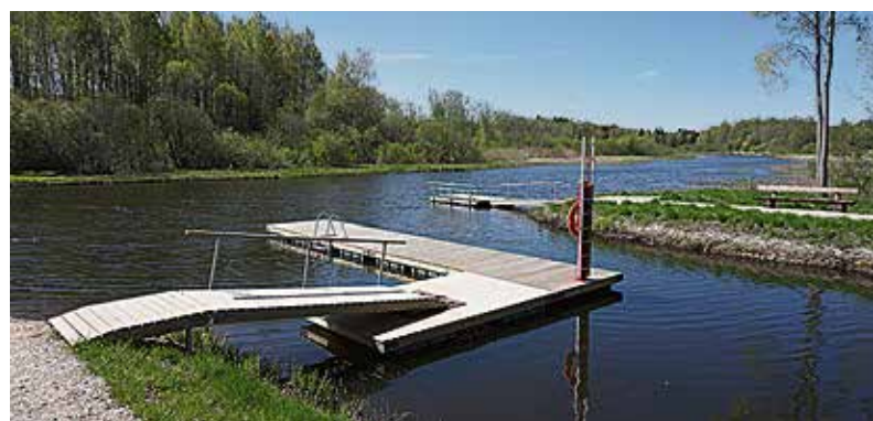
Mai keskpaiku lõpetati betoonitööd ja Surva silla ujumiskoht sai lõplikult valmis. Foto: Martin Raid
